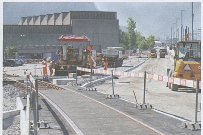
Entlang der offenen Strecke Altdorf/Rynächt wird die Kantonsstrasse Stück für Stück fertiggestellt.
