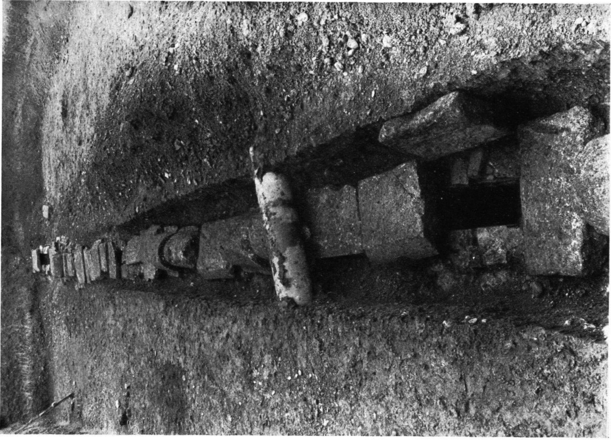
Wasserleitung im Aushub des Verwaltungsgebäudes Königsfelden (s. S. 3).
