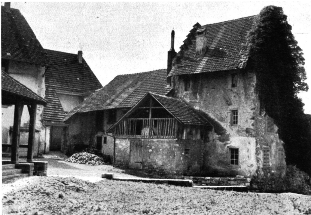
Abb. 10. Zustand vor dem Umbau.
