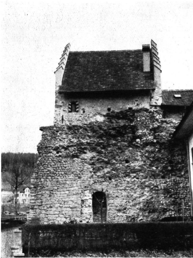
Abb. 16. Ansicht von Süden. Die spätrömische Kastellmauer.
