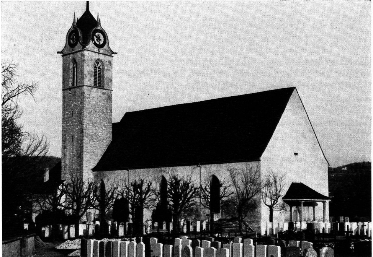
Abb. 5. Kirche Windisch vor dem Beginn der Renovationsarbeiten 1964. Ansicht von Nordwesten.
