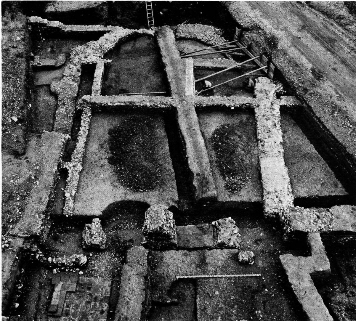
Abb. 4. Windisch-Scheuerhof 1968. Ansicht des Apsidensaaes in der Baugrube T2 von Norden. Im Vordergrund Fundamentsockel der Eingangspartie. Photo O. Lüdin.
