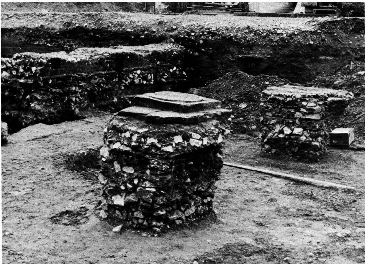
Abb. 6. Windisch-Scheuerhof 1968. Zwei Säulenfundamente der südlichen Säulenreihe in der Lagerbasilica (Baugrube B). Im Hintergrund Fundamentmauer des Apsidenbaus mit Abdrücken der Brettverschalung. Photo O. Lüdin.
