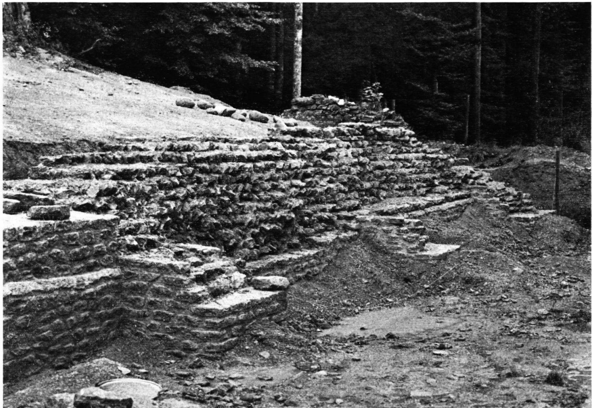
Abb. 1. Theater Lenzburg, Frontmauer vor der Konservierung
