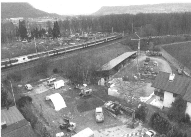
Abb. 16: Windisch-Dammstrasse 1998 (V.98.4): Situation der Grabungsstelle (im Vordergrund Mitte links). Schrägaufsicht aus Süden.
