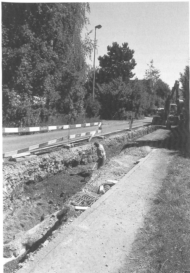
Abb. 6: Windisch-Zürcherstrasse 2000 (V.000.7): Situation des modernen Leitungsgrabens mit der römischen Strasse und dem Gräblein im Grabenprofil. Blick aus Westen von der Einmündung der Mülligerstrasse gegen den Abhang zur Reuss.
