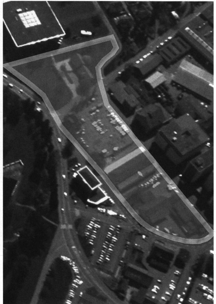
Abb. 13: Windisch-Markthallenareal. Luftaufnahme des Gebietes im Umfeld der langrechteckigen Markthalle mit markiertem Sondierungsareal.
