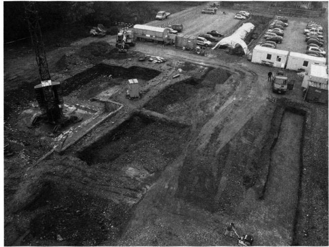
Abb. 9: Windisch-Zentralgebäude. Blick von Norden auf das Grabungsgelände gegen Ende der Arbeiten im Herbst 2004. Die Flächen im Vordergrund sind bereits teilweise wieder aufgefüllt.
