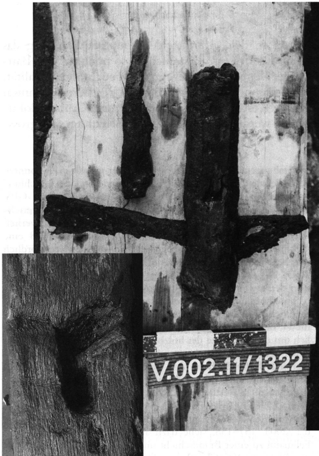
Abb. 14: Pfosten mit Ankerbalken der Holzbauphase 1 und Zapfloch in Pfosten mit schräg ausgeschlagenem Einschnitt zum Einführen der horizontalen Flechtwerkstaken der Holzbauphase 2.
