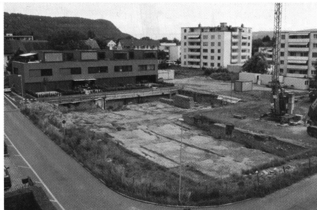
Abb. 4: Windisch-Spillmannwiese. Grabungssituation im Sommer 2006, kurz vor Abschluss der Feldarbeiten. Im Vordergrund das (vom Grabungsteam wiederverfüllte) Spitzgrabensystem, im Hintergrund ein fertig gestellter Appartement-Block, eigentlicher Anlass der Ausgrabungen.
