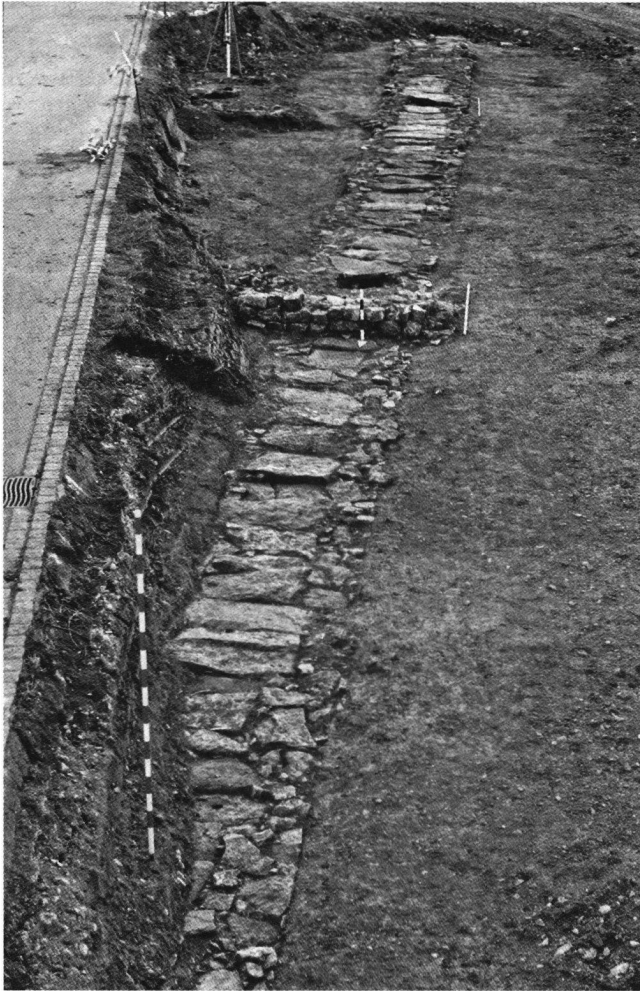
Abb. 21: Hausen-Wiesenweg. Blick auf die freigelegte Wasserleitung und ihre Abdeckplatten. Etwa in der Mitte sind die erhaltenen Reste eines Putzschachtes zu erkennen.
