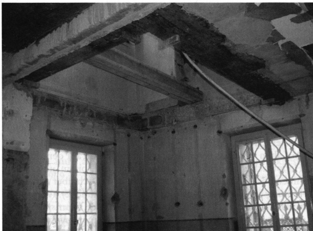
Abb. 8: Ansicht des ehemaligen Büros von Konservator Eckinger nach Entfernung der Verkleidung. In der Decke der Durchbruch für das neue Treppenhaus (Foto Architekturbüro Tschudin+Urech, Hausen).
