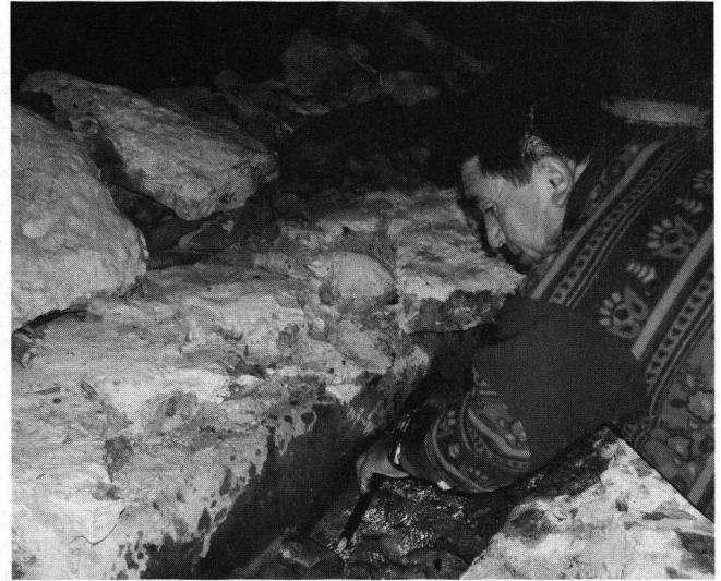
Abb. 21: Spezialisten der Firma Sekinger (Würenlos) befreien den Wasserleitungskanal vom Kalksinter.
