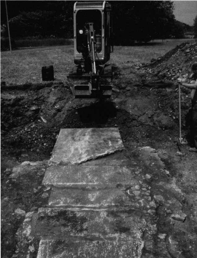
Abb. 5: Windisch-Königsfelden-Areal P1. Blick auf die «Cloaca Maxima» mit den noch intakten Betonabdeckplatten, die 1907 für die Begehbarmachung des Kanals angebracht wurden.
