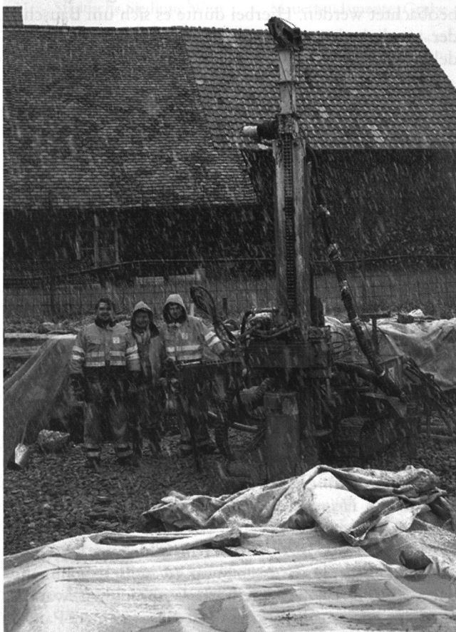
Abb. 7: Windisch, «Archäologiestätte via et porta praetoria ». Bohrung für die Fundation eines Stützpfeilers im Bereich der via praetoria .
