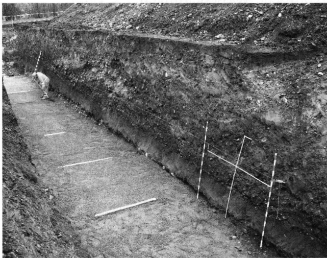
Abb. 12: Windisch-Mülimatt. Leitungsgraben für den neuen Hauptsammelkanal. Vorbereiten des Grabenbettes für das Kanalrohr. Im Südprofil ist über dem anstehenden, gewachsenen Silt eine ca. 0,2 m starke Kiesschicht (römischer Weg oder Strasse?) erkennbar. Darüber liegen moderne Verfüllschichten, die mit dem Bau des Bahndammes (1855/1862) in Zusammenhang stehen dürften.
