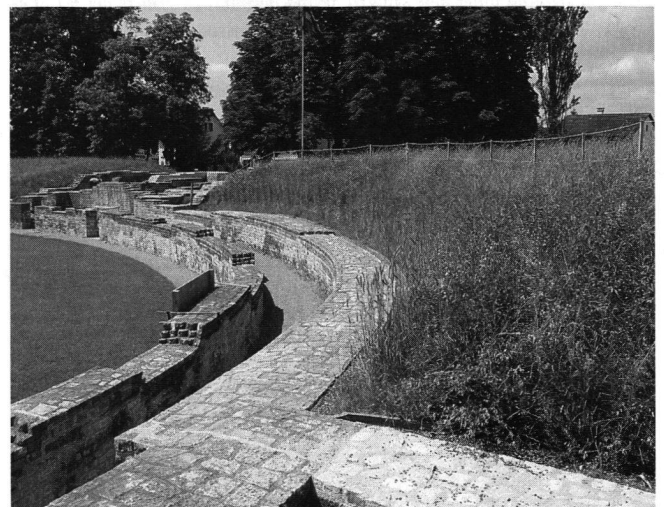
Abb. 2: Sanierte Mauern mit neu begrünter Böschung im Frühling 2009 (Foto T+U AG).
