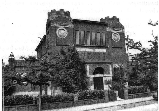
Abb. 25: Das Museum Kam in Nijmegen (NL) von 1922 wird heute nicht mehr als Museum genutzt (Foto Regionaal Archief Nijmegen).
