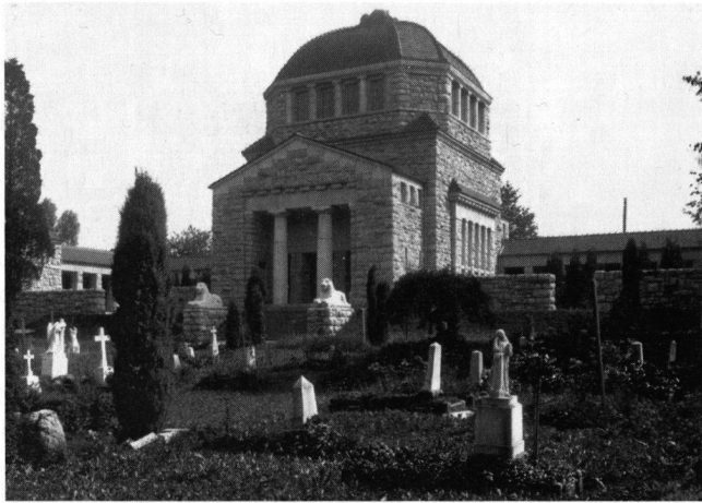
Abb. 22: Das Krematorium in Aarau von 1912. Der monumentale, tempelartige und antikisierte Bau spricht eindeutig die Architektursprache von Albert Froelich. Undatierte Fotografie (Foto Kantonale Denkmalpflege Aargau).
