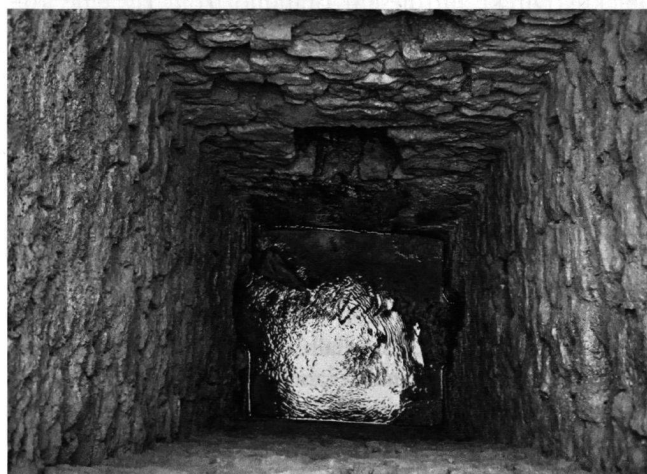
Abb. 17: Windisch-Im Winkel (V.010.5). Blick von oben in den geöffneten Schacht der römischen Wasserleitung.
