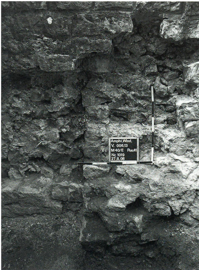
Abb. 18: Amphitheater. Vertikalfuge in der Podiumsmauer (Mauer 40) beim östlichen Arenazugang (Pos. 613). Rechts der ältere Teil der Podiumsmauer, links das nachträglich angebaute Mauerwerk, mit dem der ursprünglich breitere Arenazugang verengt wurde. Ansicht aus Nordosten.
