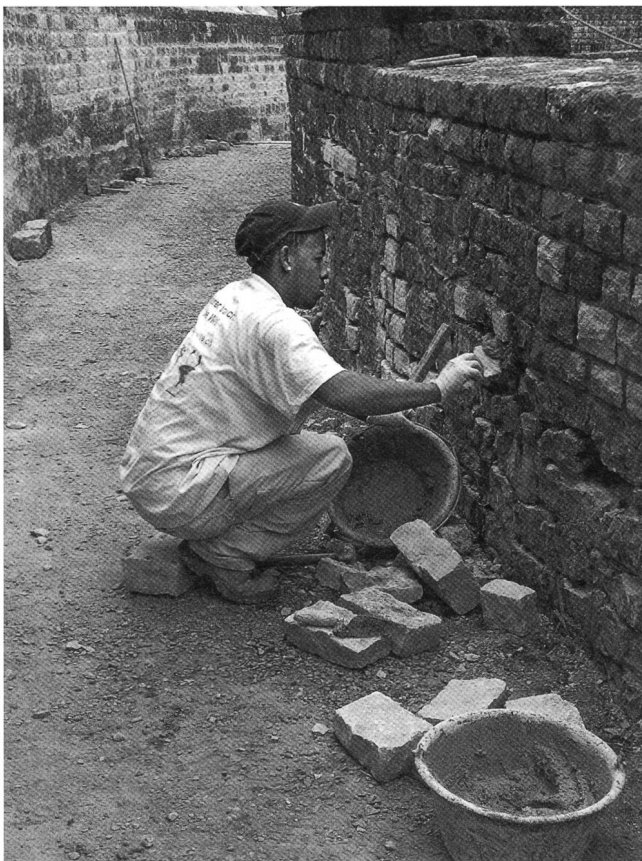
Abb. 5: Amphitheater. Sanierungsarbeiten 2006–2011. An der Aussenseite der Podiumsmauer/Arena-Umfassung (Mauer 39) werden schadhafte Stellen ausgebessert. Aufnahme während der Sanierungsetappe 2008.
