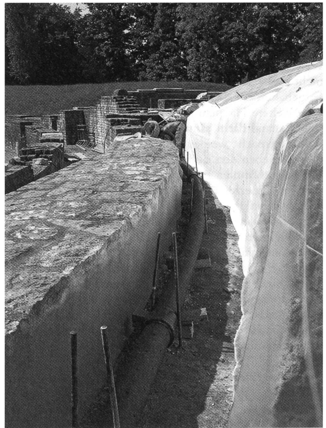
Abb. 6: Amphitheater. Einbau Sickerleitung an der Aussenseite der Couloirmauer, am Fuss der Erdböschungen der Cavea (im Bild Mauer 33 in S.2008.14). Die Sickerleitung besteht aus einem perforierten PVC-Rohr. Die Mauerschale der Couloirmauer wurde mit einem wasserundurchlässigen Mörtel abgedichtet.
