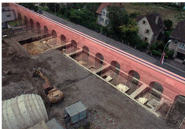
Abb. 11: Windisch-Dorfzentrum 2011/12 (V.011.1). Gesamtschau der zehn ausgegrabenen Pfeilerfundamente mit darüber rekonstruierter Aquäduktbrücke. Ansicht aus Nordosten.
