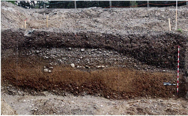
Abb. 16: Windisch-Alte Zürcherstrasse 2011 (V.011.3). Strassenkörper der römischen Strasse von Vindonissa nach Aventicum. Die massive Störung des Triasees ist deutlich zu sehen. Ansicht aus Westen.
