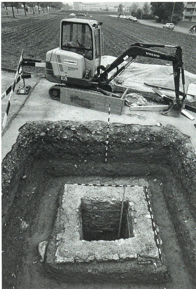
Abb. 20: Windisch-Chapfstrasse/Im Winkel 2011 (V.011.11). Blick auf den freigelegten, über 3 m tiefen Kontrollschacht Nr. 2 der römischen Wasserleitung, über freiem Grund, auf freiem Feld, der gleichfalls freigelegte Schacht Nr. 4. Ansicht aus Nordosten.
