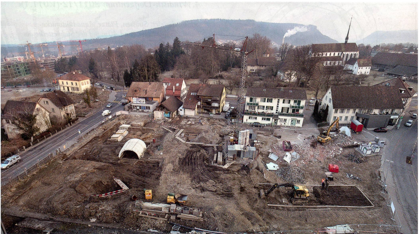
Abb. 9: Windisch-Dorfzentrum 2011/12 (V.011.1). Blick über die gesamte Grabungsfläche zu Beginn der 2. Etappe (7. März 2012). Ansicht aus Süden.
