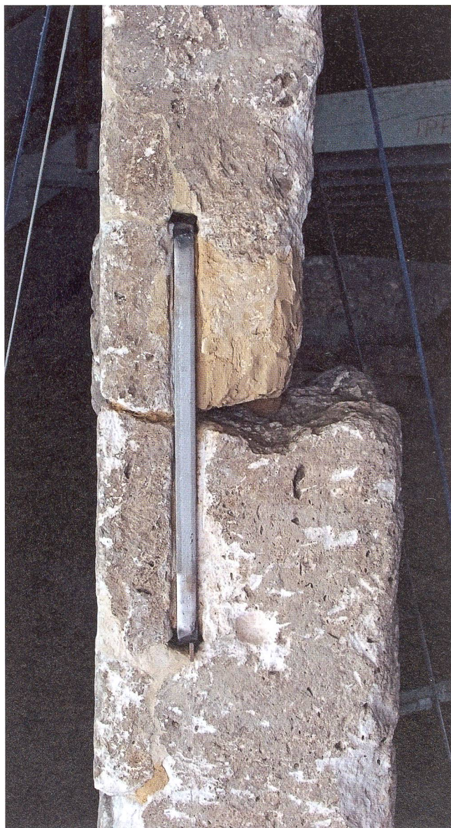
Abb. 15: Neue Inox-Stahlklammer unter Verwendung der alten Nut.
