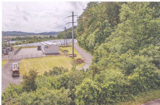
Abb. 22: Lupfig-Guggerhübel 2014 (Lup.014.1). Blick von Osten auf das sondierte Gelände am Fuss des Guggerhübels, mutmasslicher Ausgangspunkt der «toten» römischen Wasserleitung von Vindonissa .
