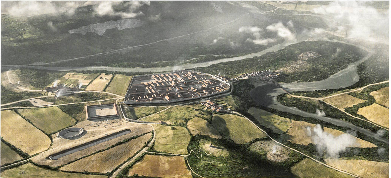
Abb. 7: 2016. Rekonstruktion von Lager und Zivilsiedlung Vindonissa im späten 1. Jh. n. Chr. (J. Trumm/ikonaut).
