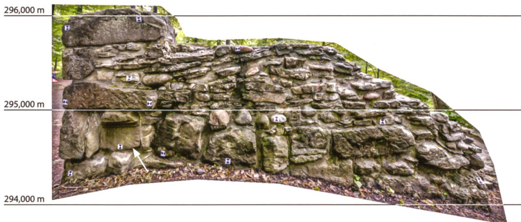
Abb. 23: Möhlin-Riburg/Bürkli (Mol. 014.5). Blick an die äussere (wallseitige) Schale der z.T. mithilfe von Spolien errichteten Westmauer (M8) des Westturms (zur Lage vgl. Abb. 21). Der im Eckverband verbaute profilierte Sandsteinquader stammt wahrscheinlich von einem Weihealtar. Blick nach Osten.
