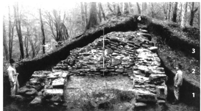
Abb. 16: Möhlin-Riburg/Bürkli (Grabung 1941). Der Westturm der Toranlage nach Abschluss der Freilegungsarbeiten (zur Lage vgl. Abb. 21). Die Aufnahme zeigt, dass die Baugrube für den Westturm sehr wahrscheinlich in den älteren, mutmasslich prähistorischen «Proto-Wall» (1) abgetieft wurde. Dieser wird seinerseits von einer jüngeren, aus Kies und Lösslehm bestehenden Wallschüttung (2) überlagert, die offensichtlich erst nach dem Bau der Nordmauer (M7) angeschüttet wurde. Die dunkle Verfärbung des obersten Teils der Wallschüttung (3) geht auf Verwitterungs- und Bodenbildungsprozesse zurück. Im Hintergrund (4) zeichnet sich möglicherweise die «Flügelmauer» bzw. deren Raubgrube ab.
