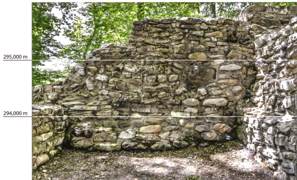
Abb. 24: Möhlin-Riburg/Bürkli (Mol. 014.5). Blick an die innere Schale der z. T. mithilfe von Spolien errichteten Westmauer (M8) des Westturms (zur Lage vgl. Abb. 21). Die 1975 vorgenommenen Sanierungsarbeiten suggerieren heute eine – de facto aber nicht nachgewiesene – Zweiphasigkeit der Mauer M8 bzw. antike Reparaturen. Blick nach Westen.
