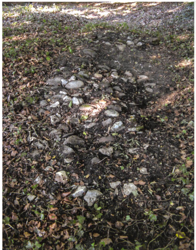
Abb. 17: Möhlin-Riburg/Bürkli (Mol. 014.5). Blick auf die Überreste des vornehmlich aus grossen Kieselwacken bestehenden Fundaments der Nordmauer des Rechteckbaus im Südosten des Hauptplateaus (zur Lage vgl. Abb. 8). Blick nach Osten.
