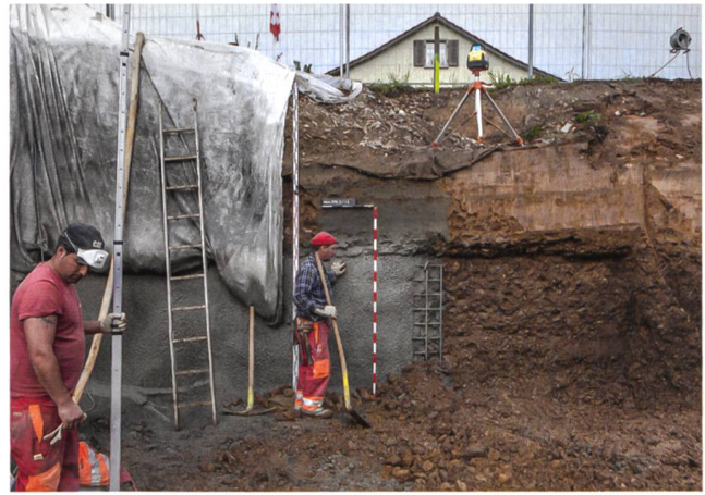
Abb. 29: Hausen-Stückstrasse 2015–2016 (Hus.015.2). Blick von Osten auf die laufenden Bauarbeiten mit dem freigelegten Abschnitt der «toten» römischen Wasserleitung nach Vindonissa . In der Baugrubenwand wird der gemauerte antike Kanal entlang seiner östlichen Wänge grob freigelegt, leicht untergraben und anschliessend mit armiertem Spritzbeton gesichert.
