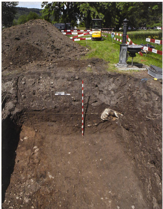
Abb. 16 Windisch-Königsfelden (Park) 2016 (V.016.2). Ansicht von Süden auf die Aushubgrube für einen neuen Kabelschacht. Ab etwa 1,5 m Tiefe sind abgesackte Schichten über dem westlichen Spitzgrabensystem des Legionslagers angeschnitten.
