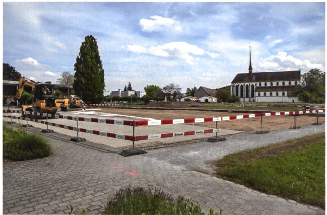
Abb. 15: Windisch-Königsfelden (Park) 2016 (V.016.2). Dauerbaustelle Königsfelden? Ansicht von Nordwesten auf den abhumusierten Bereich für einen provisorischen Parkplatz, der während des Klinikneubaus benötigt wird. Das Areal war bereits 1976 flächig ausgegraben worden (vgl. V.76.1) und konnte daher aus archäologischer Sicht problemlos «freigegeben» werden.
