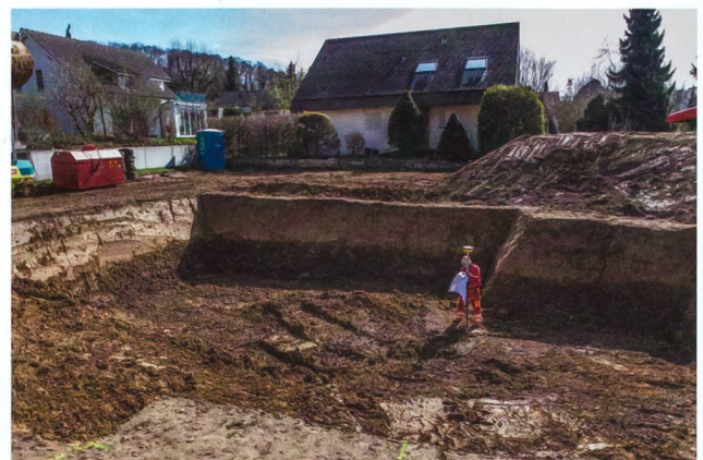
Abb. 34: Hausen-Birkenstrasse 2016–2017 (Hus.016.2). Blick von Nordwesten auf die fertig ausgehobene Baugrube während der Einmessung mit dem Trimble. Die Baugrubenwände zeigen die natürliche Schichtabfolge mit einer mächtigen Schwemmlehm-Auflage am Fusse des Lindhofhügels.
