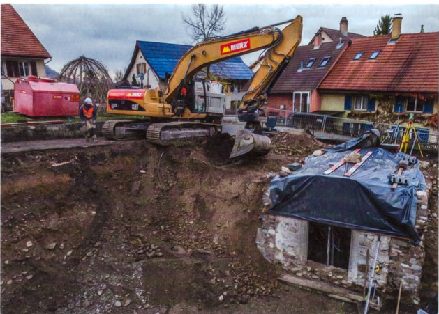
Abb. 27: Windisch-Ländestrasse 2017 (V.017.8). Blick von Südwesten auf die Baugrube nach Abriss von Haus Ländestrasse 2. Rechts im Bild der stehen gebliebene Gewölbekeller aus dem frühen 19. Jh. Das Baugrubenprofil links zeigt geologische Schichten unter neuzeitlichen Planien.
