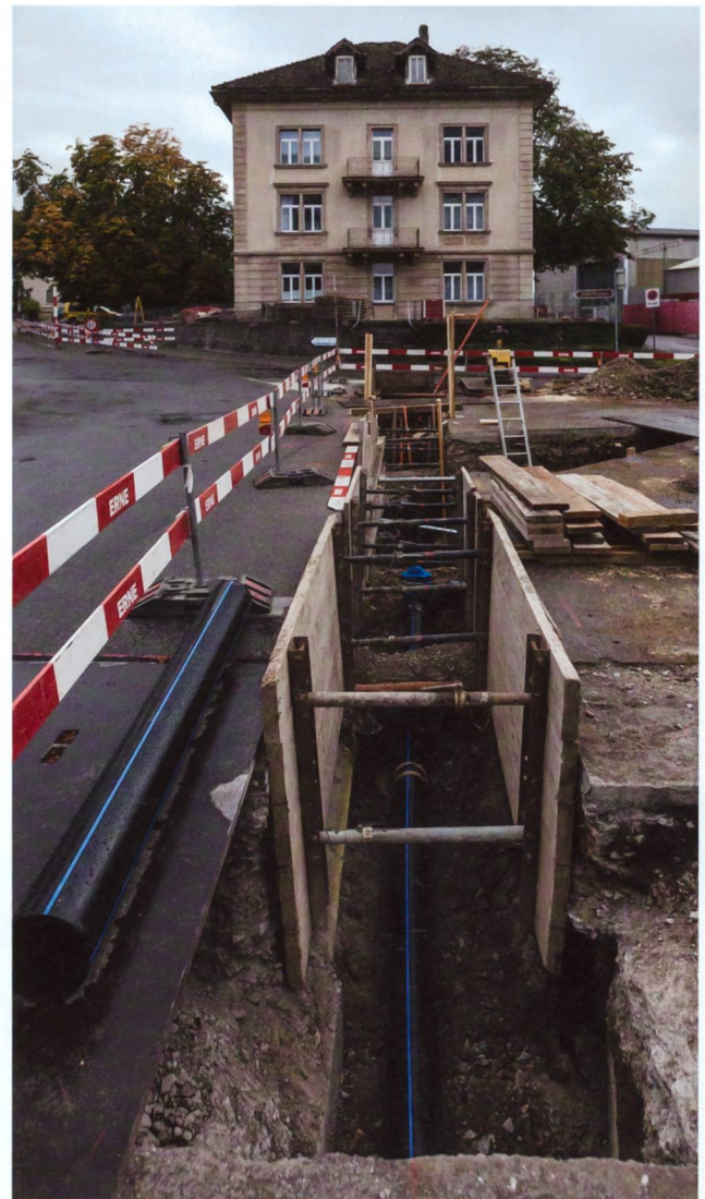
Abb. 17: Windisch-Klosterzelg 2017 (V.017.2). Blick von Osten mit dem Werkleitungsgraben an der Kreuzung Klosterzelg-/Industrie-/Reutenen- strasse. Zahlreiche alte Werkleitungen queren hier den verdolten Süssbach. Im Hintergrund das ehemalige Restaurant «Brunegg».
