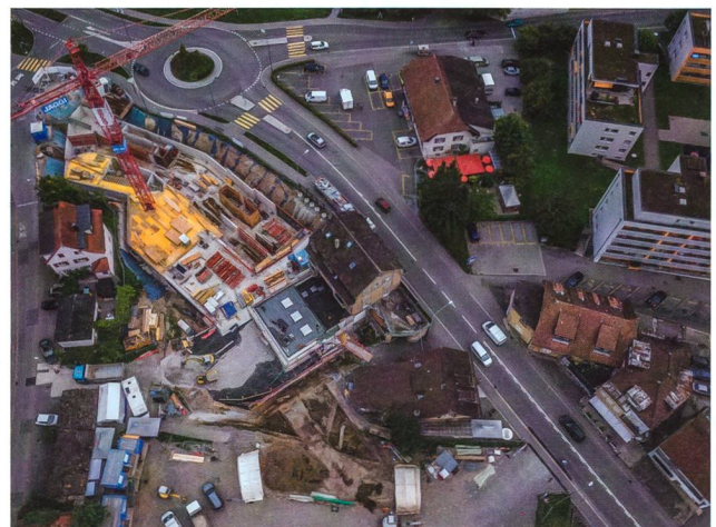
Abb. 21: Windisch-Zürcherstrasse (Urech) 2017 (V.017.5). Die Senkrechtaufnahme mittels Drohne zeigt die beengte Grabungssituation (Bildmitte unten) zwischen Zürcherstrasse, laufendem Neubauprojekt und abzureissender Liegenschaft.
