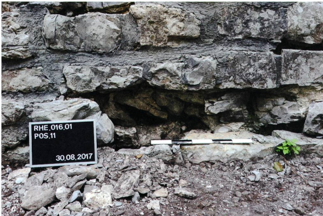
Abb. 23: Rheinfelden-Pferrichgraben 2016–2017 (Rhe 016.1). Blick an die grosse Schadstelle an der Innenschale der Westmauer (a) und Detailaufnahme des Mauerkerens (b).
