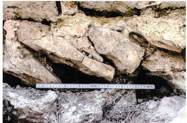
Abb. 23: Rheinfelden-Pferrichgraben 2016–2017 (Rhe 016.1). Blick an die grosse Schadstelle an der Innenschale der Westmauer (a) und Detailaufnahme des Mauerkerens (b).
