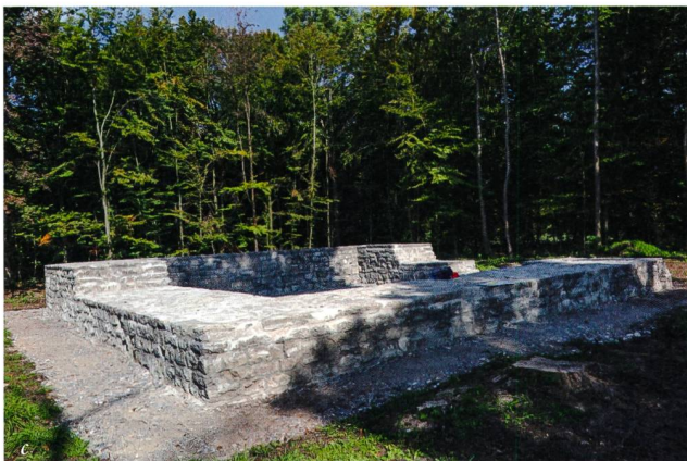
Abb. 1: Rheinfelden-Pferrichgraben 2016–2017 (Rhe 016.01). Zustand des spätantiken Wachturms vor Beginn der Sanierung (17.8.2016) (a), während der Reinigung (19.8.2016) (b) und nach Abschluss der Sanierungsarbeiten (28.9.2017) (c).
