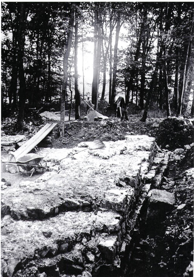
Abb. 14: Rheinfelden-Pferrichgraben (Grabung/Restaurierung 1938). Blick aus dem Turminnern an die Innenschale der Nordmauer vor Beginn der Freileigungsarbeiten (a) auf den freigelegten Nordabschnitt der Westmauer (b). Gut zu erkennen ist das kompakte Gussmauerwerk ( opus caementitium ) im Mauerkerne und dass die Flucht des aufgehenden Mauerwerks (links) deutlich von derjenigen des Fundaments abweicht (vgl. dazu auch Abb. 12).
