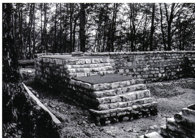
Abb. 16: Rheinfelden-Pferrichgraben (Grabung/Restaurierung 1938). Zustandsaufnahme des Mauerwerks im Bereich der Nordwest-Ecke nach dem Abschluss der Freilegungsarbeiten (a). Zustand des Nordabschnitts der Ostmauer während der Restaurierung. Im Vordergrund ist das opus caementitium im Bereich des Eingangs, in der Bildmitte sind die Negative der im Übergangsbereich zwischen Fundament und aufgehendem Mauerwerk verlegten Holzarmierung zu erkennen, links die neu aufgemauerte Innenschale der Nordmauer (b). Blick an den bereits mit Asphalt abgedeckten Südabschnitt der Ostmauer. Im Hintergrund ist die auf dem Asphalt verlegte Verschleisschicht zu erkennen, im Vordergrund die fünf Hohlräume der antiken Holzarmierung mit eingesetzten Rundhölzern (c).
