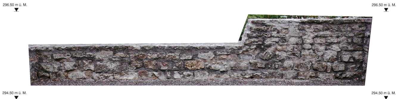
Abb. 20: Rheinfelden-Pferrichgraben 2016–2017 (Rhe.016.1). Zustand der Innenschale der Westmauer nach der Reinigung des Mauerwerks, nach dem Ausspitzen der Schadstellen und nach Abschluss der Sanierung im September 2017.
