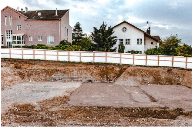
Abb. 22: Brugg-Habsburgerstrasse 2018 (Bru.018.4). Übersicht von Norden über die Baustelle mit durchgehendem, ca. 45 m langem Profil entlang der südlichen Baugrubenkante. Unter dem Humus folgt überall die natürliche quartärgeologische Abfolge mit unruhigem Schichtverlauf.
