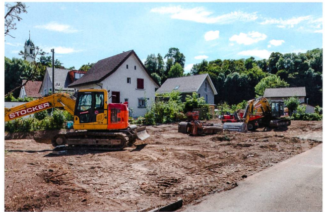
Abb. 26: Windisch-Nordtorweg 2018 (V.018.4). Blick von Nordosten auf die Baustelle nach Roden, Gebäudeabbruch und Humusabtrag. Im Hintergrund links markiert die Windischer Dorfkirche die höher gelegene Terrasse mit dem römischen Legionslager.
