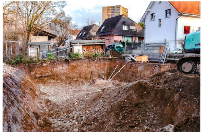
Abb. 25: Windisch-Bachstrasse 2018 (V.018.7). Blick von Westen auf die teilweise ausgehobene Baugrube mit der geologischen Schichtabfolge im Bereich des Süssbachs.
