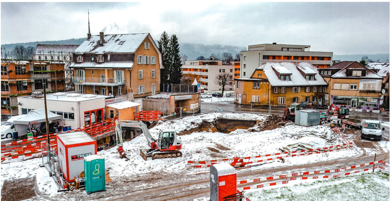
Abb. 23: Windisch-Zürcherstrasse (Urech) 2017–2018 (V.017.5). Übersicht von Süden auf die Grabungssituation im Februar 2018. Im Mittelgrund die Zürcherstrasse, die hier teilweise die südliche Umwehrung des Legionslagers überlagert. Im Hintergrund links die Klosterkirche Königsfelden.
