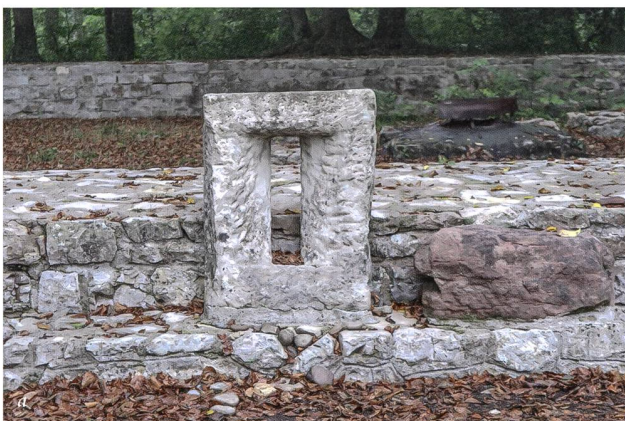
Abb. 15: Wällbach-Stelli (Wal.015.1/Wal.019.80). Blick auf das 2019 entfernte Podest, auf dem seit 1955 die Lichtscharte und das Postament ausgestellt waren (a). Blick auf die Aussenschale der Ostmauer (b). Gut zu erkennen ist der Absatz zwischen der hervorragend erhaltenen Fundamentzone und der 1955 teilweise neu aufgemauerten Mauerschale (Zustand vor der Sanierung).
