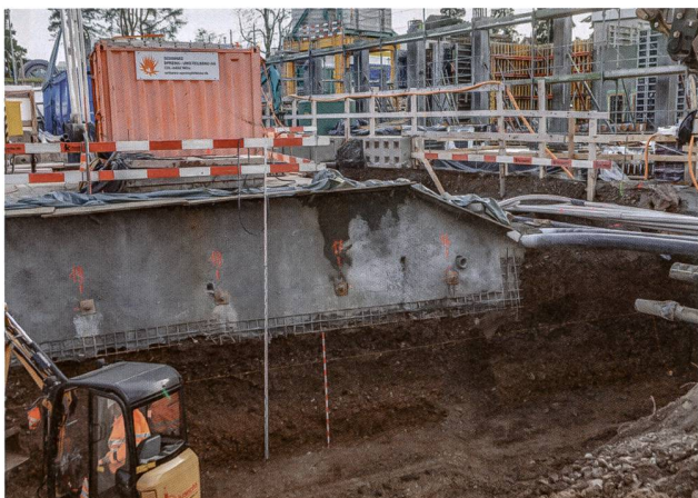
Abb. 22: Windisch-Steinackerstrasse 2018–2019 (V.018.1). Blick von Nordosten auf die südliche Baugrubenwand für die Tiefgaragenverbindung. Unter modernen Planien zeigt sich beim rot-weissen Jalon eine schwach ausgeprägte römische Kulturschicht über den anstehenden Kiesen und Lehmen.
