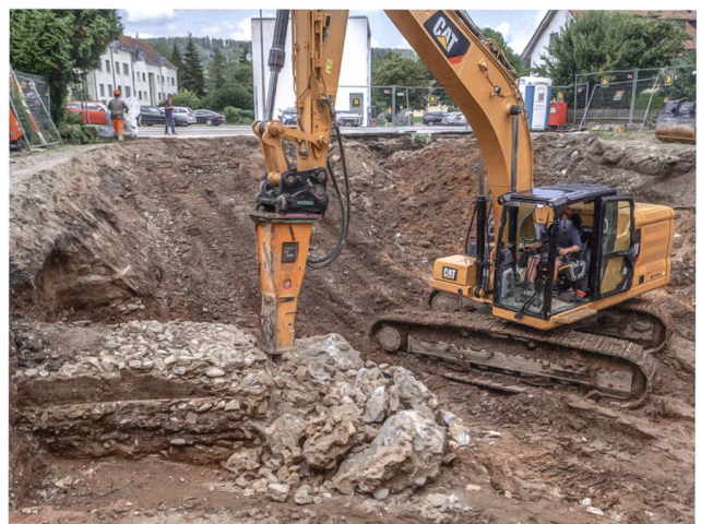
Abb. 12 Windisch-Dorfstrasse (Huber) 2018–2019 (V.018.2). Abbruch eines betonharten römischen Fundaments des «Apsidenbaus» mit dem Hydraulikmeissel.
