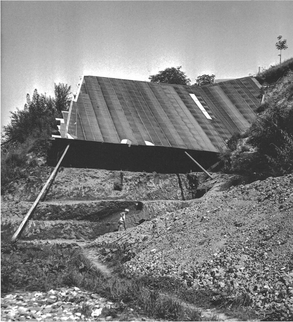
Abb. 4: Windisch-Schutthügel, um 1950. Blick von Nordwesten auf die Nord-Süd verlaufende Profilwand während der systematischen Abbauarbeiten zwischen 1948 und 1952. Im unteren Bereich die jeweils ca. 1 m hohen Abbaustufen, oben ein provisorisches Schuttdach.
