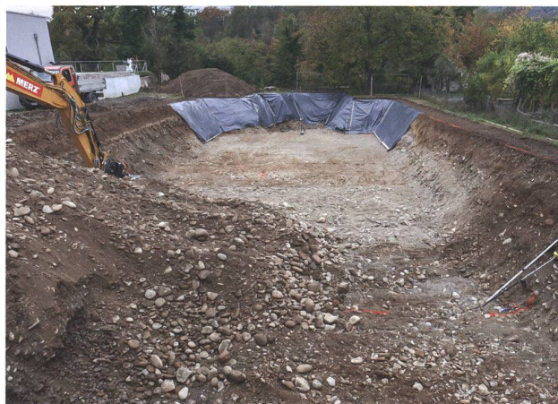
Abb. 32: Gebenstorf-Ringstrasse 2020 (Geb.020.1). Blick von Osten auf die weitgehend ausgehobene Baugrube auf Parz. 1114. Im Hintergrund die buschbestandene Böschungskante hinunter zur Aare-Reuss-Mündung.
