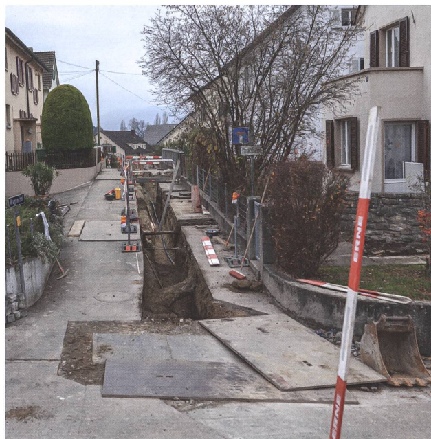
Abb. 19: Windisch-Wagnerhof 2020 (V.020.5). Blick von Osten auf die laufenden Werkleitungsarbeiten in der Quartierstrasse «Wagnerhof». Beim Einfamilienhaus rechts im Vordergrund fand man 1918 ein Steinkistengrab mit einem gestempelten Ziegel der spätrömischen Legio I Martia.
