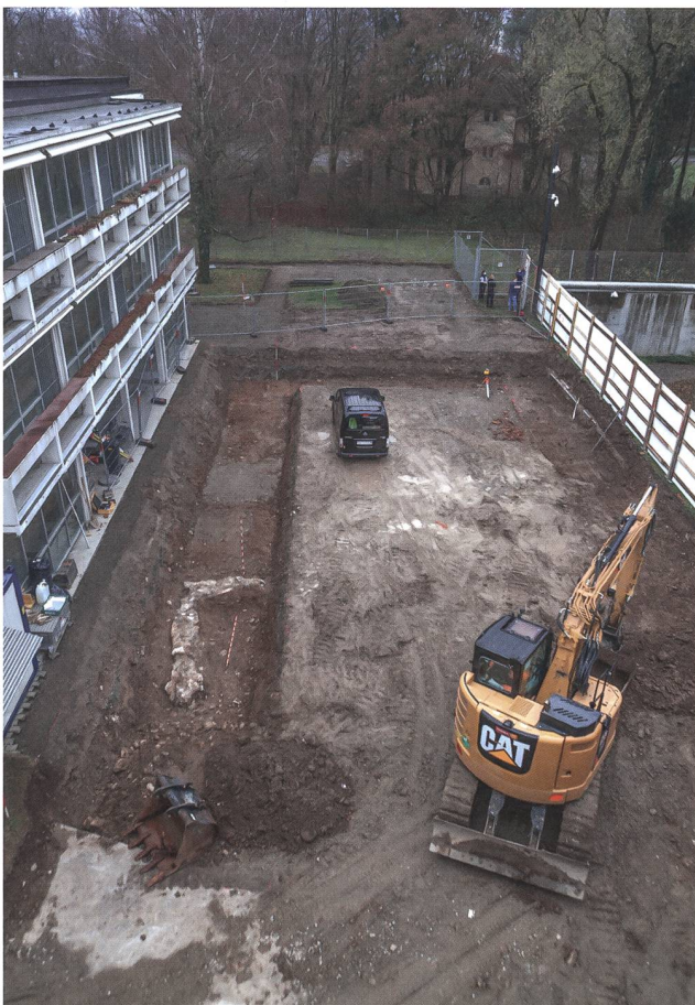
Abb. 10: Windisch-Forensik 2020 (V.020.11). Die letzten Reste des Spitals des römischen Legionslagers weichen den Neubauten der heutigen Psychiatrischen Klinik. Blick von Westen auf die Baugrube mit dem stehengebliebenen Mauerwinkel des valetudinariums. Im Hintergrund, von Bäumen teils verdeckt, die 1911 gebaute Turnhalle von Windisch.
