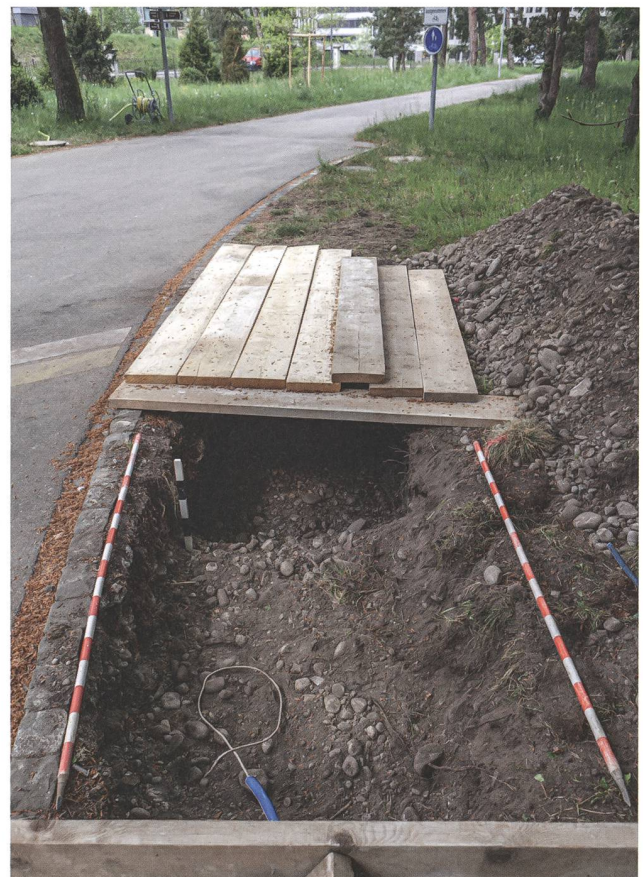
Abb. 8: Windisch-Königsfelden (Klinikareal) 2020 (V.020.3). Blick von Südosten in eine frisch ausgehobene Baugrube für eine der neuen Infostelen. Der 50–80 cm tiefe Erdeingriff beim ehemaligen Portierhaus der Psychiatrischen Klinik liegt grösstenteils im Bereich einer alten Kandelaberleitung.
