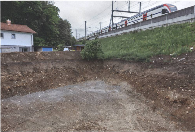
Abb. 25: Windisch-Bühlweg 2020 (V.020.2). Blick von Südosten auf die weitgehend fertig ausgehobene Baugrube. Im Hintergrund rechts verläuft der Bahndamm der SBB-Linie Brugg-Baden. Im Hintergrund links markieren die Bäume des «Bühlwäldchens» den Steilhang zur Terrasse mit dem Legionslager.
