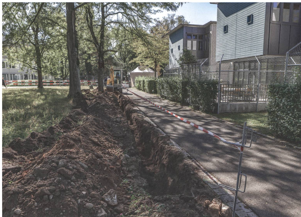
Abb. 9: Windisch-Königsfelden P4 (Kandelaber) 2020 (V.020.8). Blick von Norden auf den offenen Werkleitungsgaben westlich des Wohnheims «Sternbild» (rechts im Bild). Wo der heutige Asphaltweg der Klinik verläuft, lag in römischer Zeit eine gekieste Gasse zwischen zwei Nord-Süd orientierten Mannschaftsbaracken des steinernen Legionslagers.
