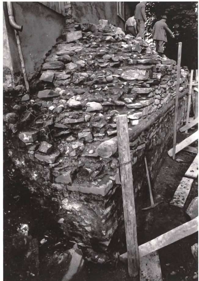
Abb. 2: Filzbach (GL) Vordemwald. Blick auf die Nordostecke des spätrepublikanischen/frühaugusteischen Wachturmes während der Sanierung im Jahre 1960.
