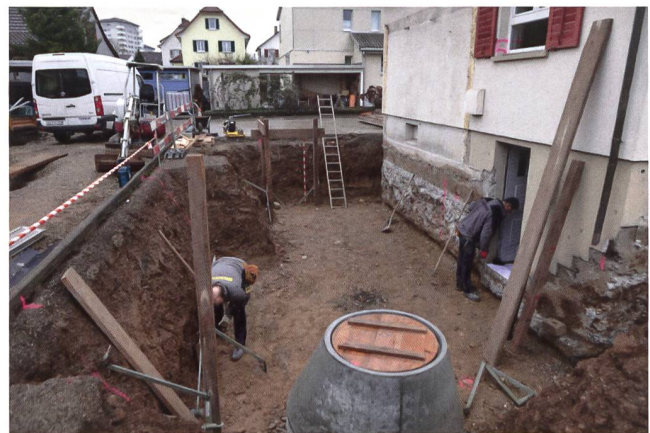
Abb. 12: Windisch-Bruneggstrasse 2021 (V.021.1). Blick von Norden auf die laufenden Bauarbeiten mit der natürlichen Schichtabfolge in den Baugrubenprofilen.
