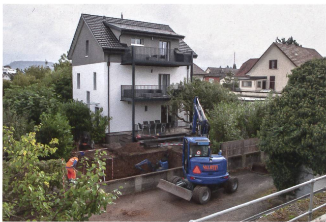
Abb. 13: Windisch-Kindergartenstrasse 2021 (V.021.10). Blick von Westen auf die laufenden Bauarbeiten.
