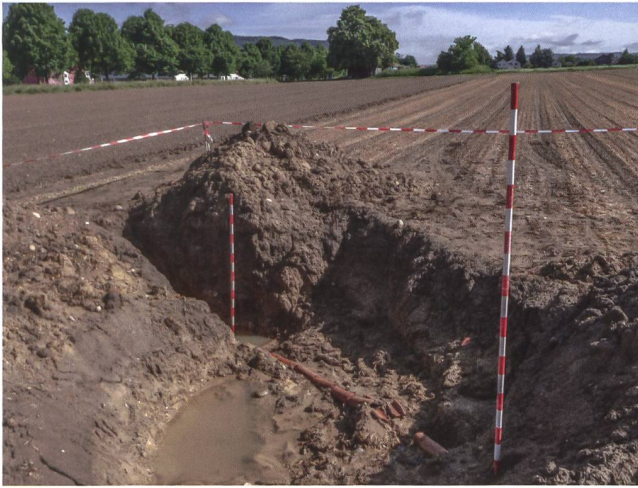
Abb. 25: Windisch-Heumatte 2021 (V.021.7). Blick von Süden auf das «Baggerloch» mit der teilweise freigelegten, defekten Tonröhrendrainage. Die nicht mehr intakte, «tote» Wasserleitung von Vindonissa verläuft unmittelbar rechts des Jalons im Vordergrund. Die zweite, bis heute Wasser führende Leitung verläuft westlich parallel zur Baumreihe am linken oberen Bildrand.
