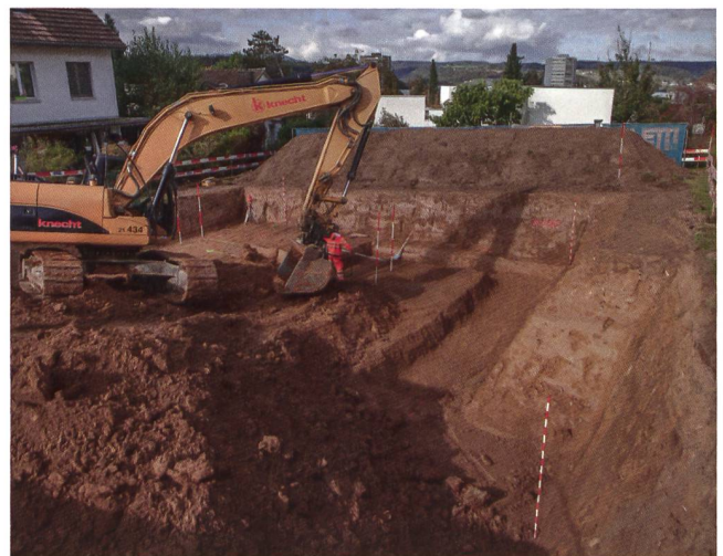
Abb. 16: Windisch-Chapfstrasse 2021 (V.021.9). Blick von Osten auf die laufenden Aushubarbeiten mit mächtigen Schwemmlermschichten in den Baugrubenwänden.
