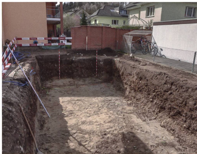
Abb. 24: Windisch-Zelgliackerstrasse 2020–2021 (V.020.10). Blick von Norden auf die weitgehend fertig ausgehobene Baugrube mit der aufgeschlossenen quartärgeologischen Schichtenfolge.
