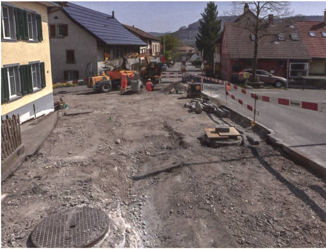
Abb. 19: Windisch-Unterwindisch (Dorfstrasse) 2021 (V.021.5). Blick von Westen auf die hier nur oberflächlich eingreifenden Werkleitungssanierungen im Bereich der Kreuzung Dorfstrasse–Kirchenfeldstrasse–Ländestrasse.
