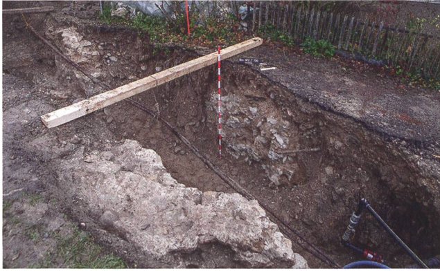
Abb. 11: Brugg-Altenburg 2022 (Bru.022.7). Blick von Südosten auf den Werkleitungsgraben am Osteingang der spätrömischen Befestigung. Im Profil aufgeschlossen ist das opus caementitium-Fundament eines halbbrund vorspringenden Torturms, dessen Fundamentsohle nicht erreicht ist. Vorne links weitere Fundamentreste, wohl ein Unterbau des antiken Eingangs- bzw. Zufahrtbereichs.
