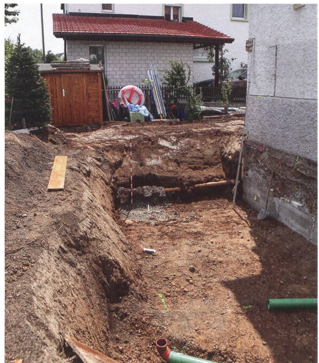
Abb. 17: Windisch-Arenastrasse 2022 (V.022.3). Arbeitsfoto von Norden auf die Baugrube für den ostseitigen Hausanbau, ohne archäologische Befunde.
