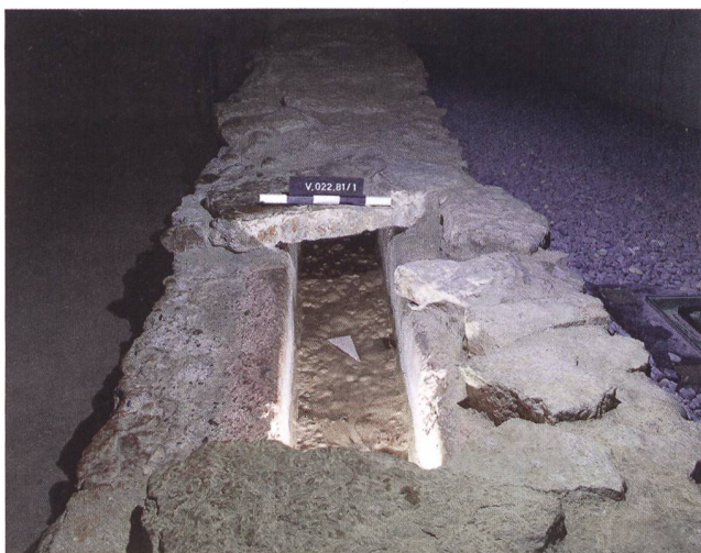
Abb. 30: Windisch-Lindhofstrasse (Wasserleitung) 2022 (V:022.81). Blick von Norden in die römisch-mittelalterliche Wasserleitung im Keller des Pflegezentrums. Nach langer Hitzeperiode ohne Niederschläge ist die Leitung im August 2022 praktisch trocken gefallen, auf der versinterten Kanalsohle stand nur noch ein dünner Wasserfilm.
