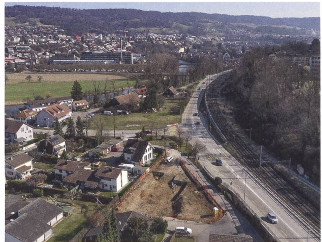
Abb. 23: Gebenstorf-Chameracher 2022 (Geb.022.1). Drohnensfoto von Südwesten mit den laufenden Bauarbeiten an der Chameracherstrasse im Vordergrund. Im Mittelgrund die Wiese im «Steinacher» mit den römischen Steinbauten. Rechts die SBB-Linie Brugg-Baden, bei deren Bau 1856 mehrere römische Soldatengrabsteine gefunden wurden.
