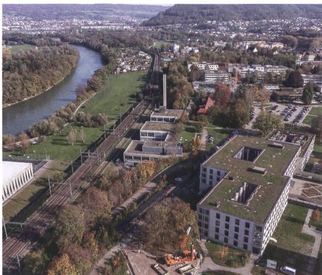
Abb. 15: Windisch-Königsfelden 2022 (V.022.8). Drohnensfoto von Westen auf die laufenden Grundwasserbohrungen vor der Westfassade des Klinikneubaus der PDAG (orange Baumaschine im Vordergrund).
