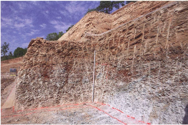
Abb. 26: Umiken-Chilhalden 2022 (Umi.022.1). Blick von Südosten auf den unteren Baugrubenbereich. Die 4 m hohe, mit dem Baggermeissel abgespitzte Profilwand zeigt die geologische Schichtabfolge mit hellbraunem Schwemmléhm, grünlichem Molassesandstein und Nagelfluh. Links oben markiert der Waldrand den Verlauf der historischen Bözbergstrasse.
