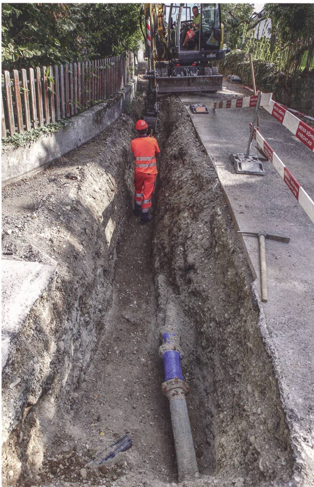
Abb. 16: Windisch-Klosterzelg 2022 (V.022.4). Arbeitsfoto von Norden auf die laufenden Werkleitungsarbeiten am Nordende des Blumenwegs. In diesem Areal wurde 1906 ein gut erhaltener römischer Kalkbrennofen gefunden.
