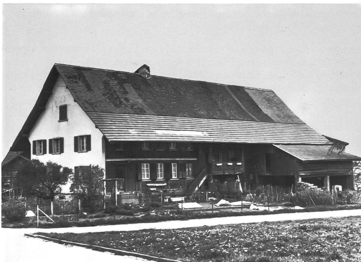
2. La ferme de Jean Berger, au lieudit « Fin de Charmey ». Le pignon a été refait en maçonnerie au XX e siècle.
