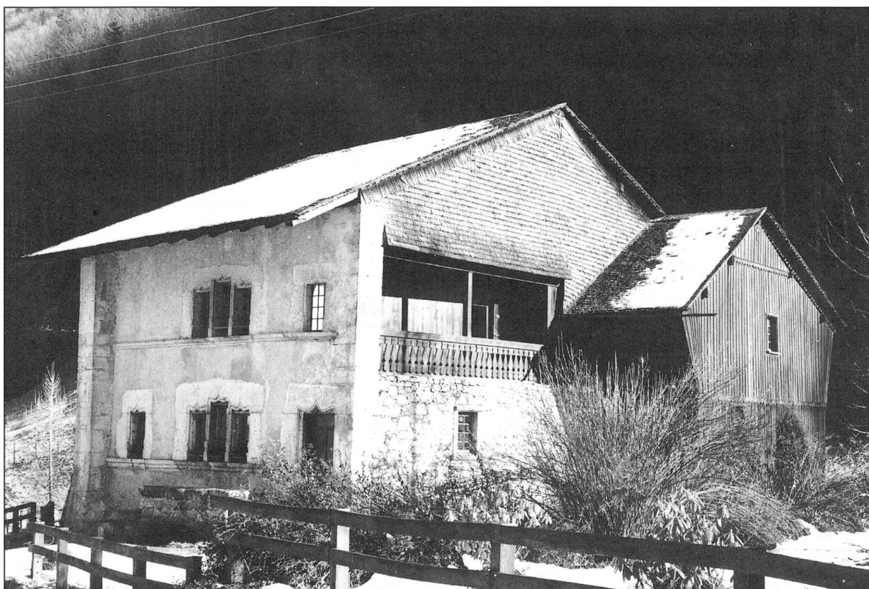
La maison du banneret Pierre de la Tinaz (1666) à Grandvillard, emblème architectural de ce XVIII e siècle fromager.
