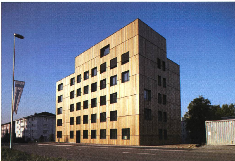
Cet immeuble à Steinhausen, dans le canton de Zoug, est le premier bâtiment de six niveaux réalisé intégralement en bois. Photo Renggli AG, Sursee
