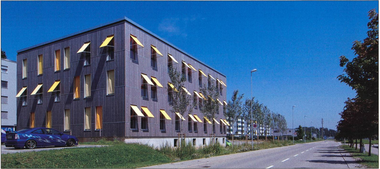
Le bâtiment Green Offices, à Givisiez. Photo Corinne Cuendet, Clarens
