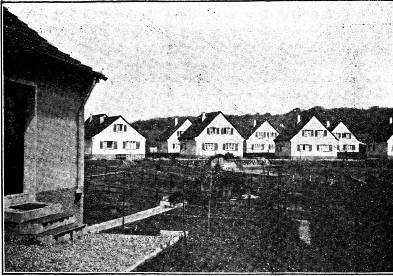
La forêt derrière les maisons
