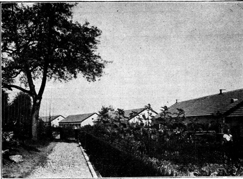
Vue prise à l'angle sud du Groupe des constructions.
