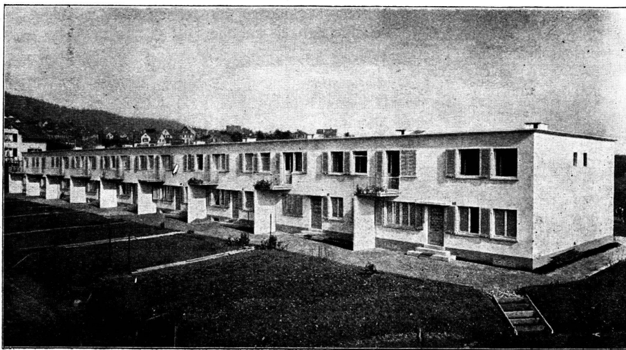
Vue d'une des façades. Sur le toit à remarquer les ventilations.
