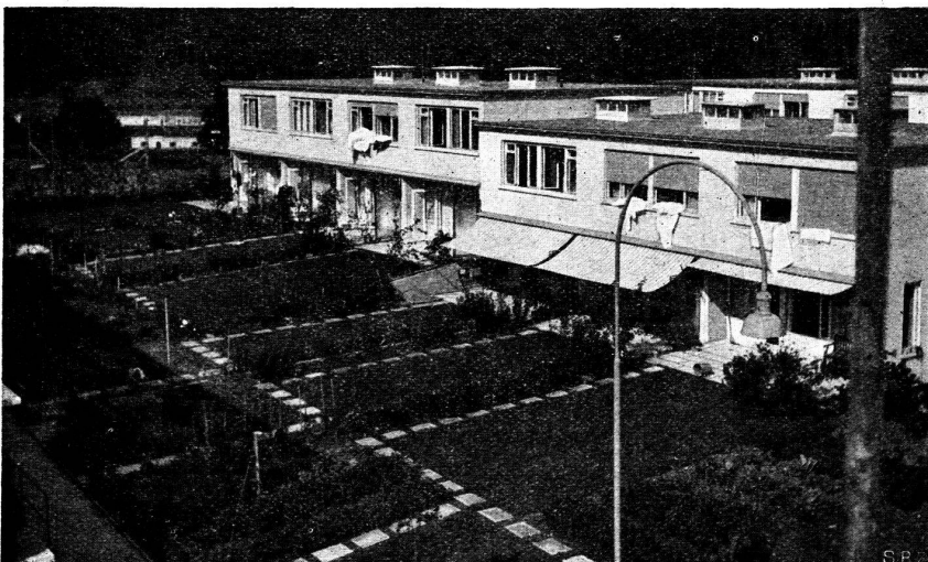
Vue générale des maisons familiales de cinq chambres, Types C.
