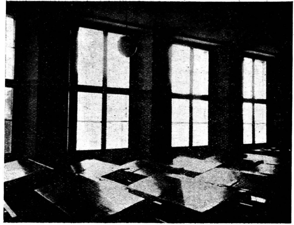
Mauvais éclairage : Les trumeaux jettent des ombres sur certains pupitres. Le rythme des murs et vitrages fatigue les yeux. Assombrissement du fond de la classe. Appui et couverture des fenêtres trop importants. Impression d'être emprisonné.
