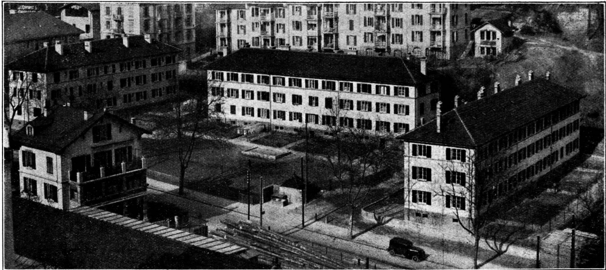
Vue d'ensemble, du sud-ouest.
