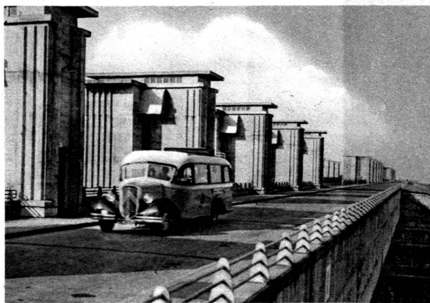
Le groupe d'écluses de Den Oever.
