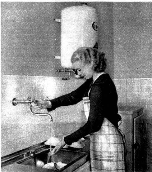
Petit boiler à gaz.
