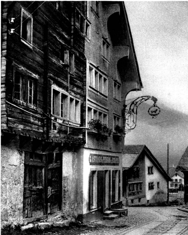
Hospenthal : Le chalet uranais se divise souvent en deux propriétés. Ici un cas particulier : une moitié en madriers, l'autre recouverte de bardeaux
