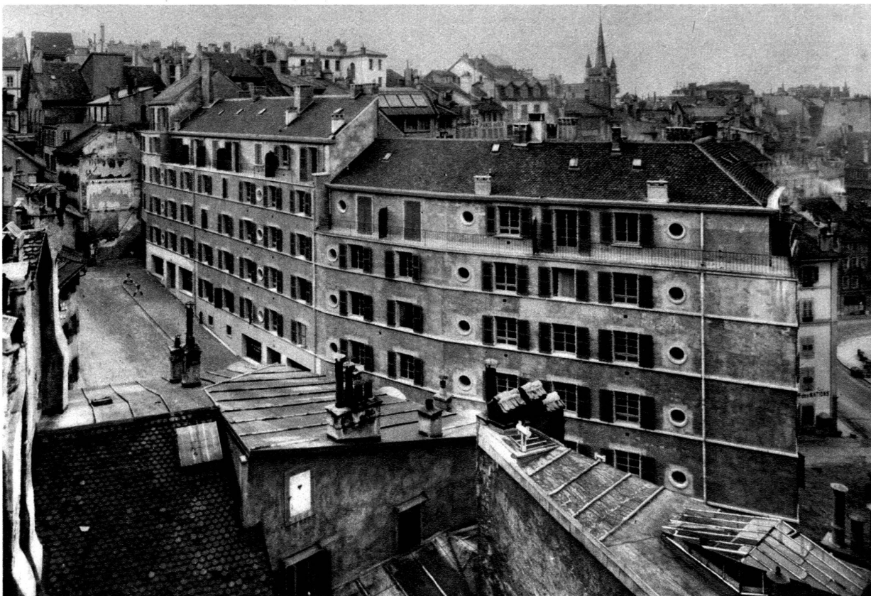
Les nouvelles constructions de la rue Cheneau - de - Bourg
