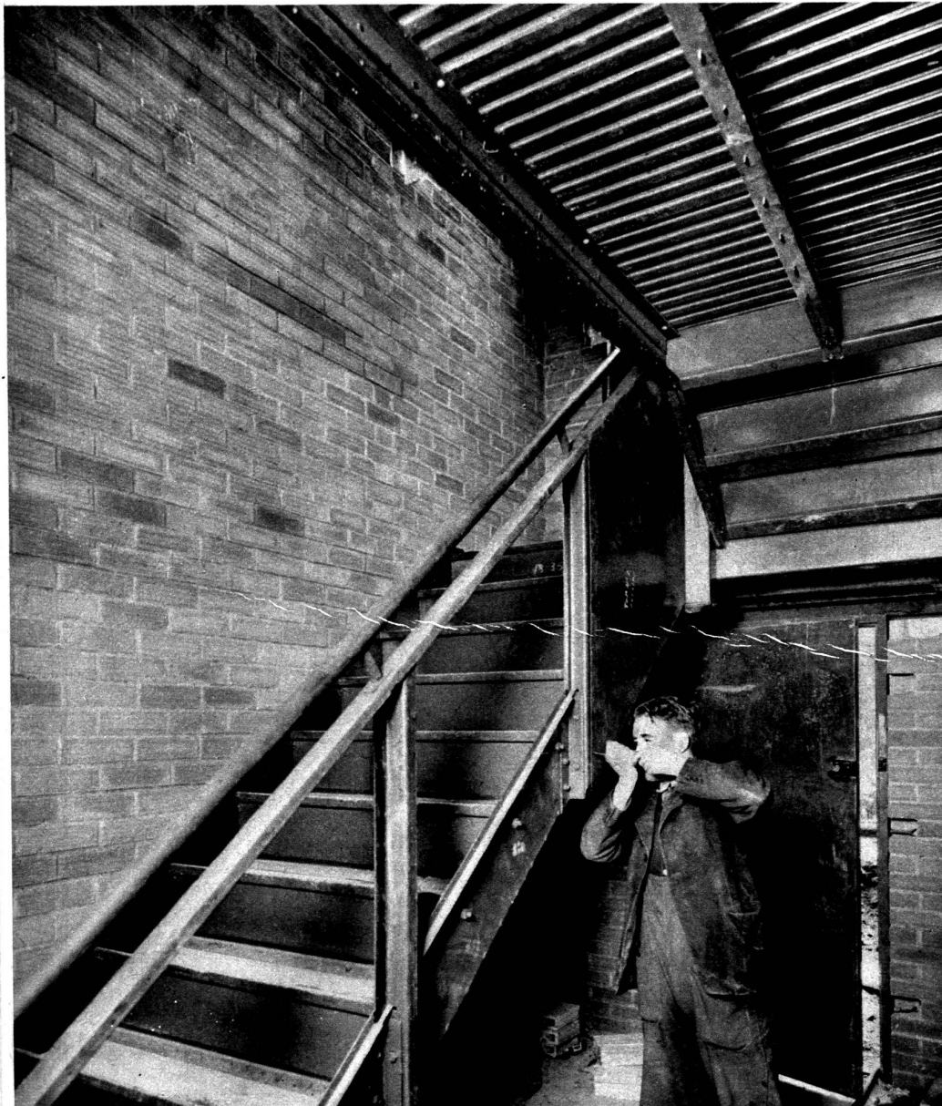
Montage de la balustrade de l'escalier.
