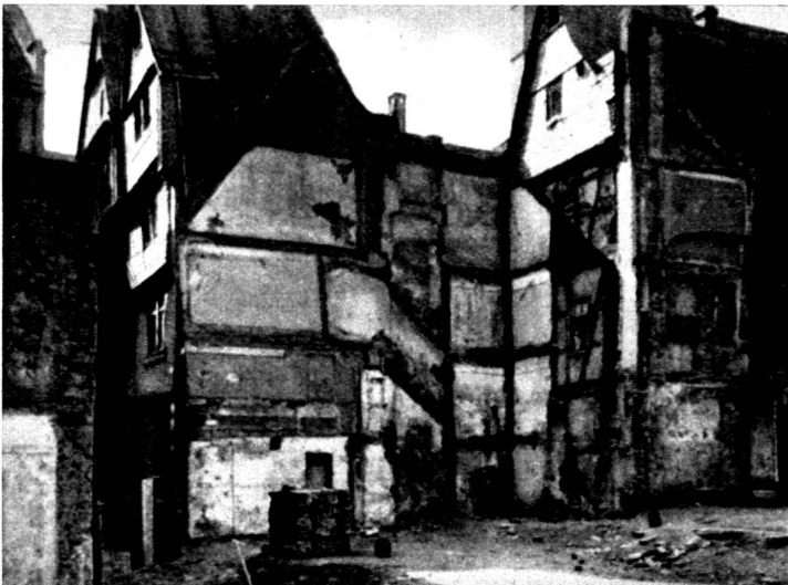
Le même angle que ci-dessus, après le déblaiement, mais avant les remises en état.
